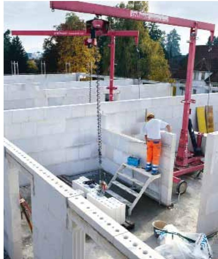
Une organisation optimale du chantier garantit le bon déroulement des travaux. Il convient notamment de limiter la distance entre les palettes de briques et leur zone de mise en œuvre.
